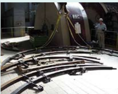
Montage der Tilgerringe
